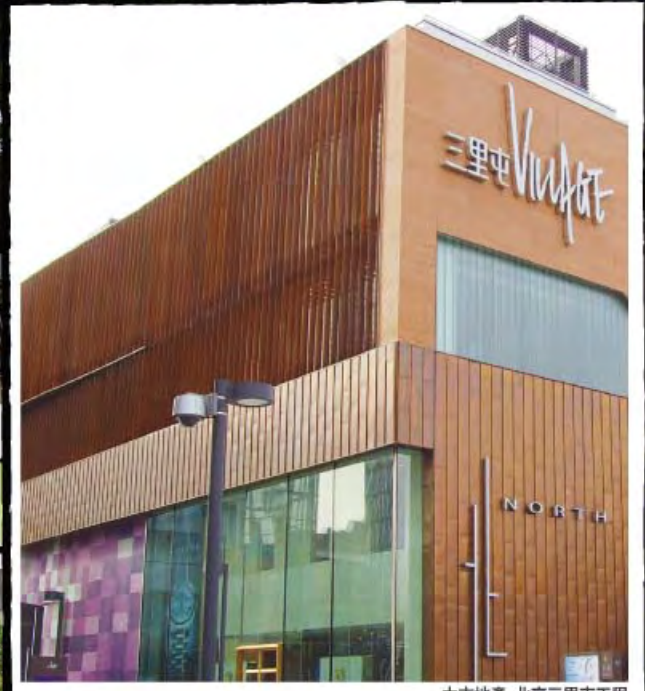
太古地產 北京三里屯工程 Sanlitun Village, Beijing
